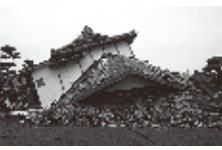
▲ 会館の隣。搬入口から出てすぐの民家
